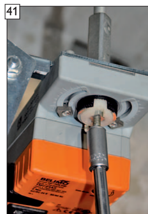
Fixierung der Stellmotorwelle in der Fixierschraube. (Montageansicht zu Bild 40)
