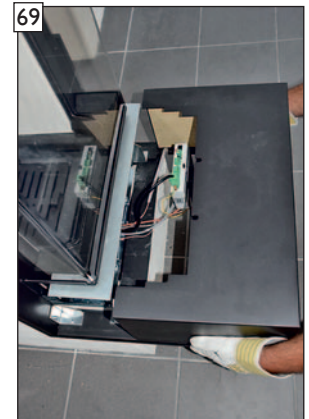
Abschlussarbeit - Montage des Ofentisches
