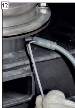
Befestigungsschraube der Stellhebelwelle am Zuluftadapter lösen und entfernen.
