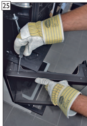
25 Neutrale Glashalteleiste montieren.
