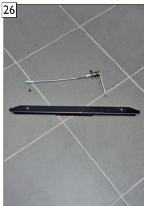
26 Der demontierte Stellhebel sowie die Glashalteleiste sind dem Bauherrn dokumentiert zu übergeben und im Protokoll zu vermerken.
