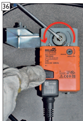
Freilaufaste gedrückt halten und die Aufnahme der Stellmotorwelle ganz nach links drehen.
