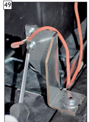
Zugentlastung für Verbindungskabel montieren.
