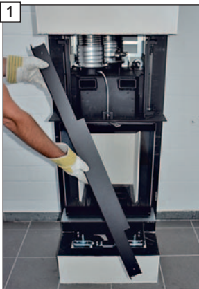
1 Frontverkleidung, Ofentisch und Blendenbauteile entfernen.
