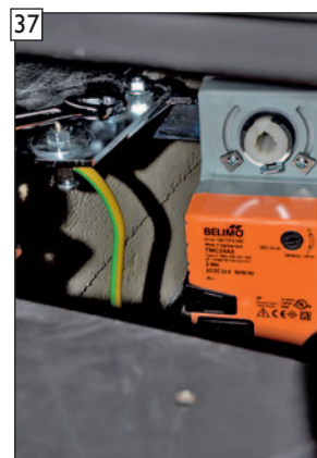
Stellmotorhalterung mit montiertem Stellmotor am Gleitlager befestigen.
