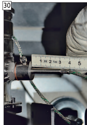
30 Abgastemperaturfühler in Anschlussklemme einstecken. WICHTIG! Restüberstand 40 mm genau einhalten!
