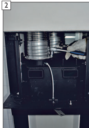
2 Zuluft- und Abgasadapter von der Brennkammer lösen.
