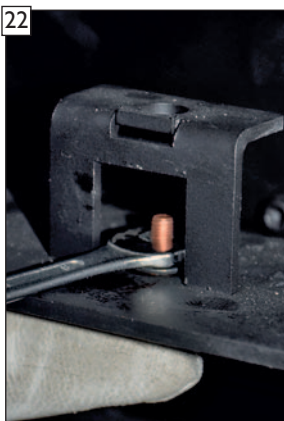
... in die Stellhebelbohrung als Blindstopfen montieren.
