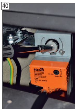
Stellmotorwelle von hinten in den Stellmotor einschieben und fixieren.
