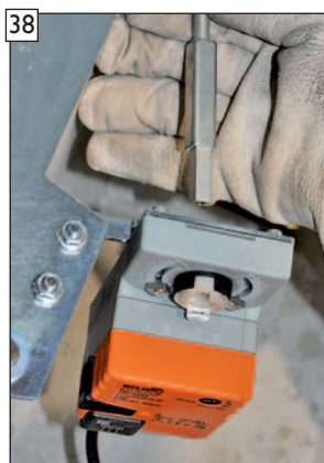
Einstecken der Stellmotorwelle in den Stellmotor. (Montageansicht zu Bild 40)
