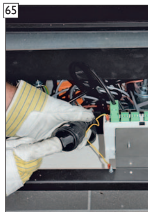
230V-Netzstecker der Steuerung mit der bauseitigen Steckdose verbinden.
