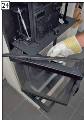
24 Obere Glashalteleiste mit den Stellhebelpositionen 1 bis 3 entfernen.
