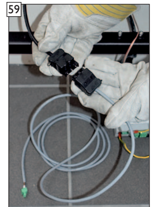
Anschlussstecker des Stellmotors mit dem Stecker des Stellmotor-Verbindungskabels verbinden.
