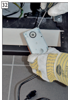
Befestigungsschrauben an der Stellmotorrückseite herausschrauben.
